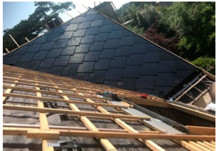
Chantier toiture Saint-Malo - France
