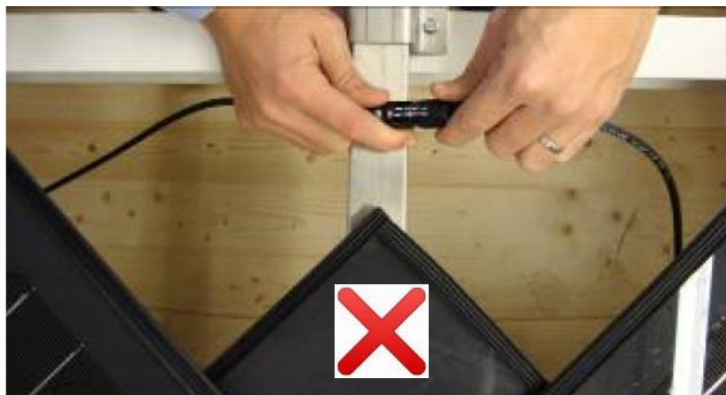
Figure 4 : Illustration de la connexion électrique entre deux tuiles lors de la pose
