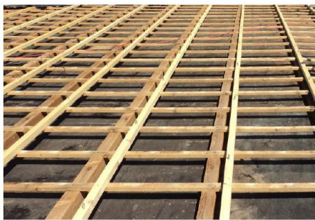
Exemple de lattage bois correctement placé
