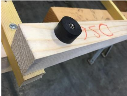
Figure 3 : Rondelle autour de pièce de distance
