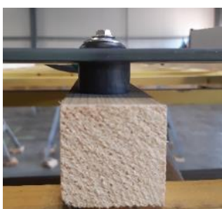
Figure 2 : Rondelle d'appui sous tuile
