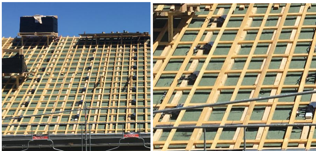
Exemple de lattes bois et lattes neige correctement placées
