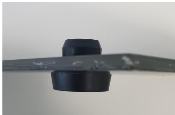
Figure 4 : Anneau d'appui dans trou de tuile
